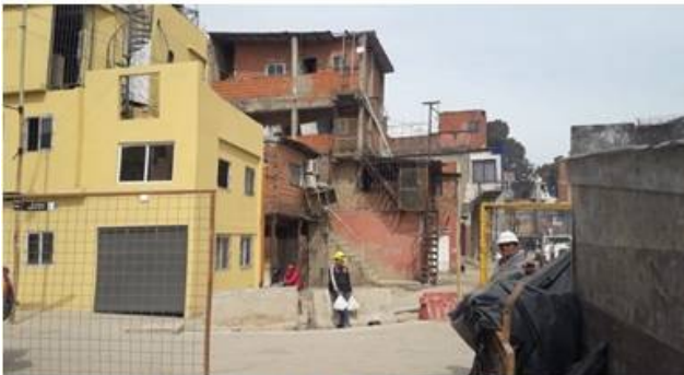
El entorno en el ingreso al obrador
