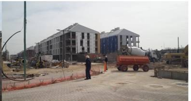
Viviendas en construcción próximas a la Escuela
