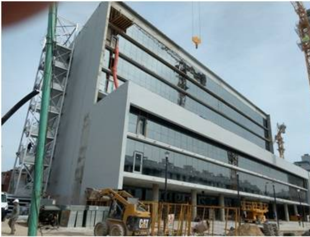
El Ministerio de Educación, estado actual de la obra
