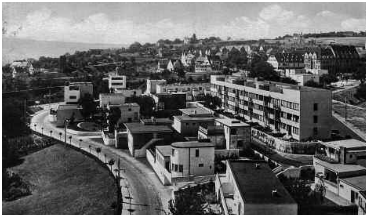
A la derecha atrás, el gran bloque de Mies y al fondo a la derecha la tira de viviendas de Peter Oud; al fondo a la izquierda, las dos casas blancas de Le Corbusier; delante de ellas dos viviendas individuales de Gropius. Observar el contraste con el entorno existente, que se puede ver al fondo.
